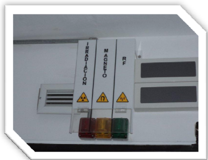
Figura 8– Alarmas luminosas indicadoras de los estados operativos del ciclotrón.
