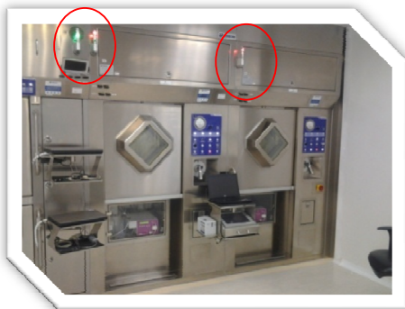
Figura 14 – Alarmas luminosas indicadoras de los estados operativos de las celdas calientes.
