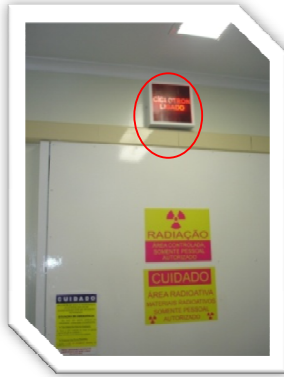
Figura 9 – Alarma luminosa indicadora de que el haz se encuentra habilitado.
