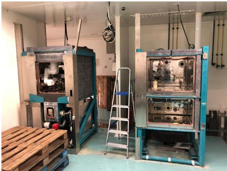
**Figura 28:** Desmantelamiento de las celdas calientes (Colección CNEN/Brasil).
