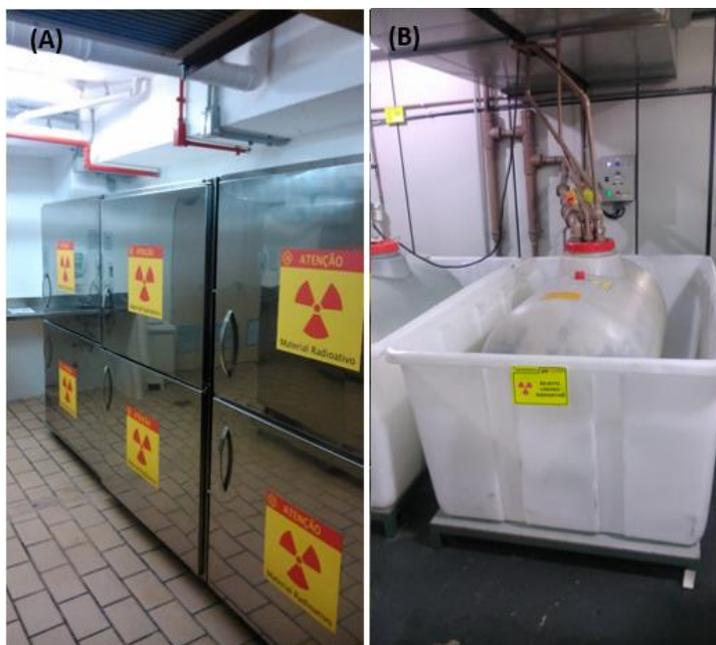
**Figura 10:** (A) Recintos blindados para el almacenamiento de desechos radiactivos sólidos y (B) tanques de decaimiento para el almacenamiento de desechos radiactivos líquidos (Colección CNEN/Brasil).
