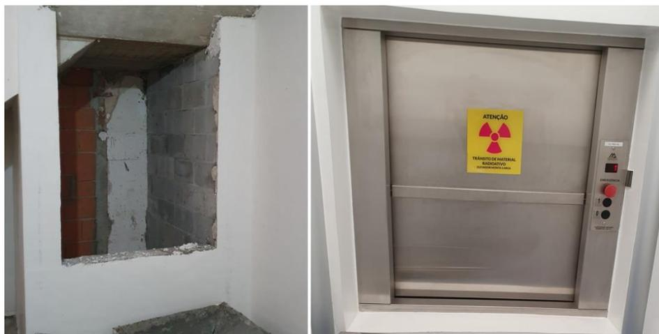
**Figura 18:** Etapa de construcción del foso del montacargas para el transporte de material radiactivo y el ascensor instalado (Colección CNEN/Brasil).
