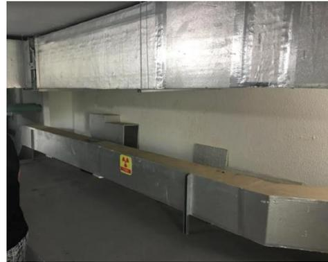
**Figura 16:** Ducto de ventilación caliente (proveniente de la celda caliente) señalado (Colección CNEN/Brasil).
