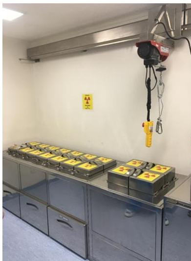
**Figura 3:** Contenedores blindados para el almacenamiento de fuentes y generadores en uso y un gancho dedicado para la abertura del blindaje y transporte de los generadores (Colección CNEN/Brasil).
