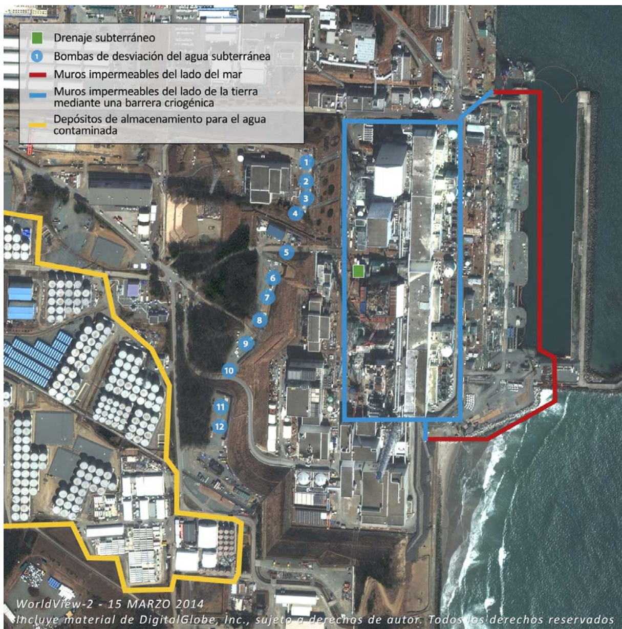
Fig. 5.5. Ilustración de las actividades de gestión del agua. A la izquierda se ven los depósitos de almacenamiento del agua contaminada [286].
