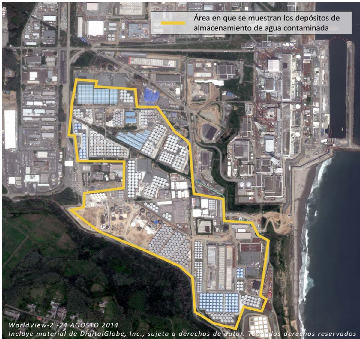
Fig. 5.8. Vista aérea de la zona del emplazamiento donde se encuentran los depósitos de almacenamiento de agua [301].
